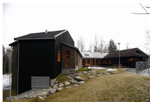
Frydenhaug barnehage er utvidet og rehabilitert
