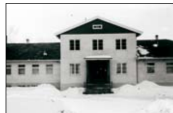
Inngangen på Åslund før den ble bygget på i 1976.
