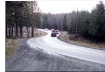
Tidligere gikk veien nede til høyre for bilene før man startet på omleggingen som nødsarbeid. Omleggingen ble fullført i 1960-årene.
