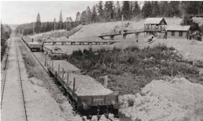
Anlegget sett fra syd der gangbroen går over i dag. Til høyre for huset med lokomobilen skimtes vedstablene. Jernbanesporet over Åsmåsan har allerede fått et lag med pukk. Foto: Jernbanemuseet
