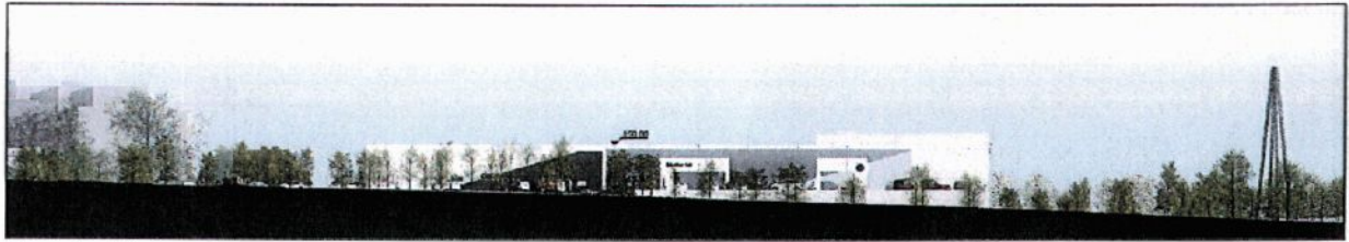
Fasade F1 nord
