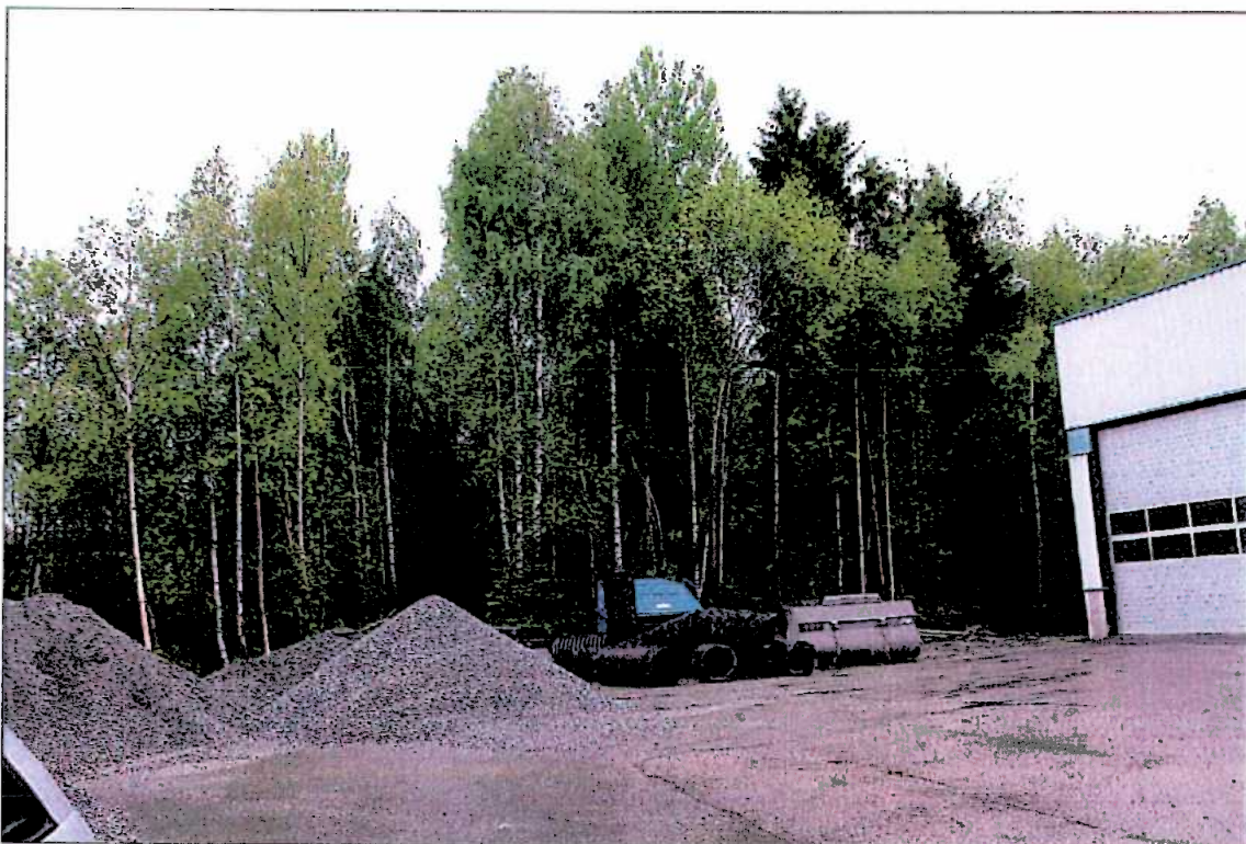
Figur 1: Det undersøkte området grenser opp mot Myrveien 16 i sør, en lagerbygning som disponeres av kommunalteknisk avdeling. Tatt mot N.
