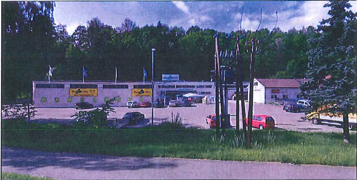
Bebyggelsen i Nessetveien 69 sett fra veien.
