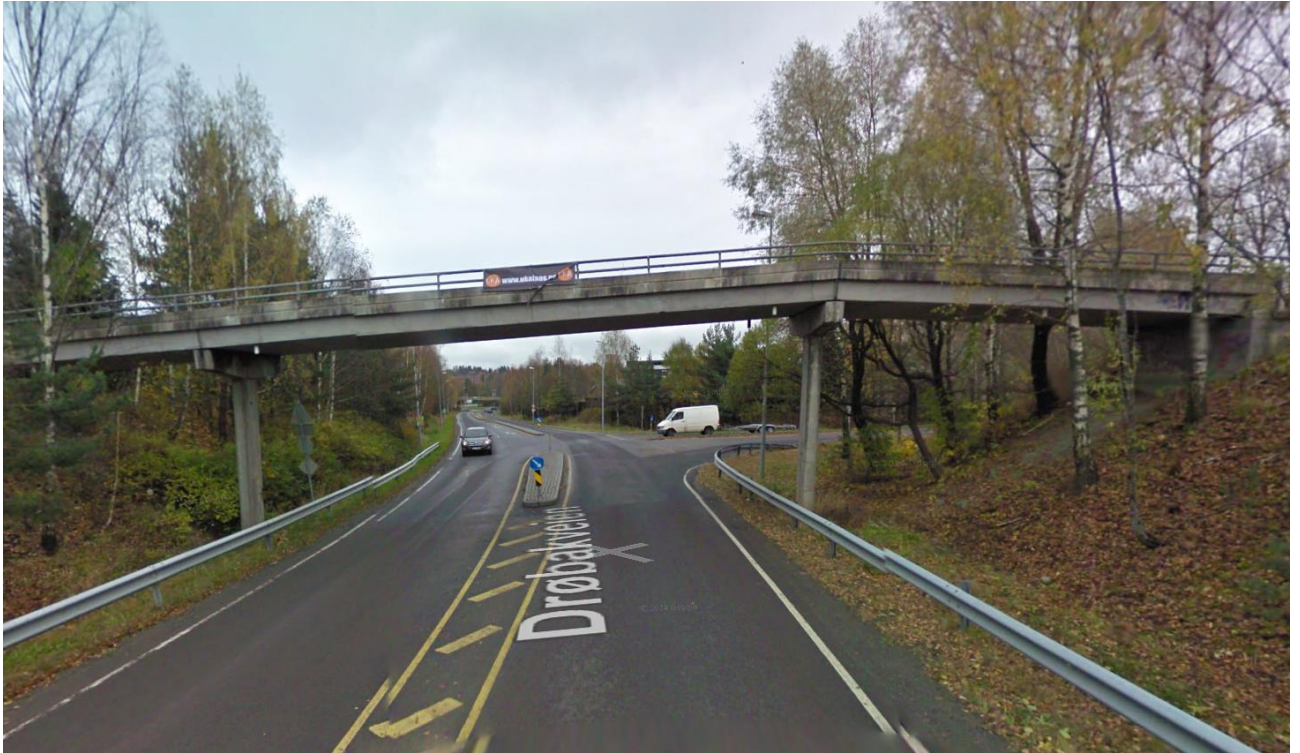
Bilde 2 : Drøbakveien (Fv152) sett mot øst i krysset med Rådhusplassen (Kilde : Google, okt. 2010)
