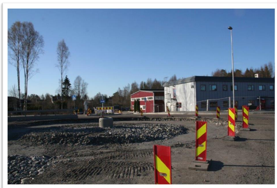
Figur 7 Rundkjøring under bygging, sett fra nord (A2 arkitekter)
