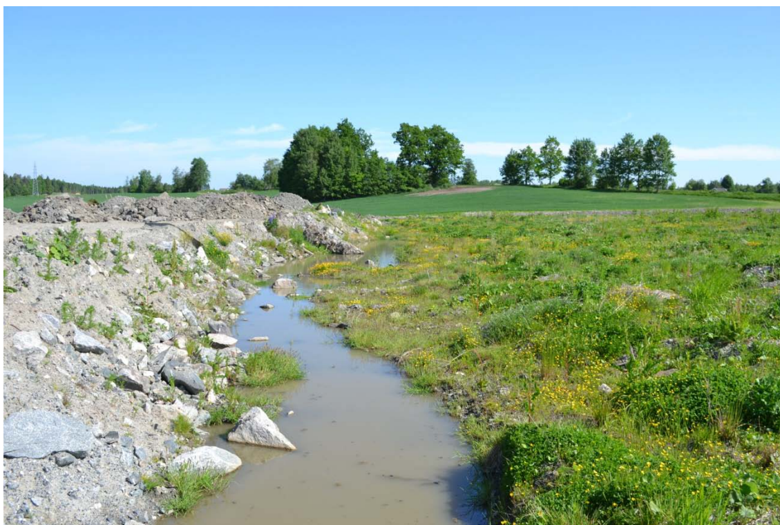
Bilde 5. Område som er delvis fylt med løsmasser og som skal settes i stand til jordbruksproduksjon.
