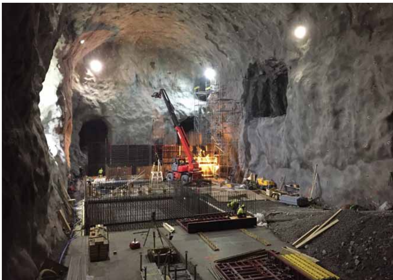
Pågående utbygging av et nytt rensetrinn (OREA) for avløpsvann ved stor tilrenning til NRAs rensesanlegg
