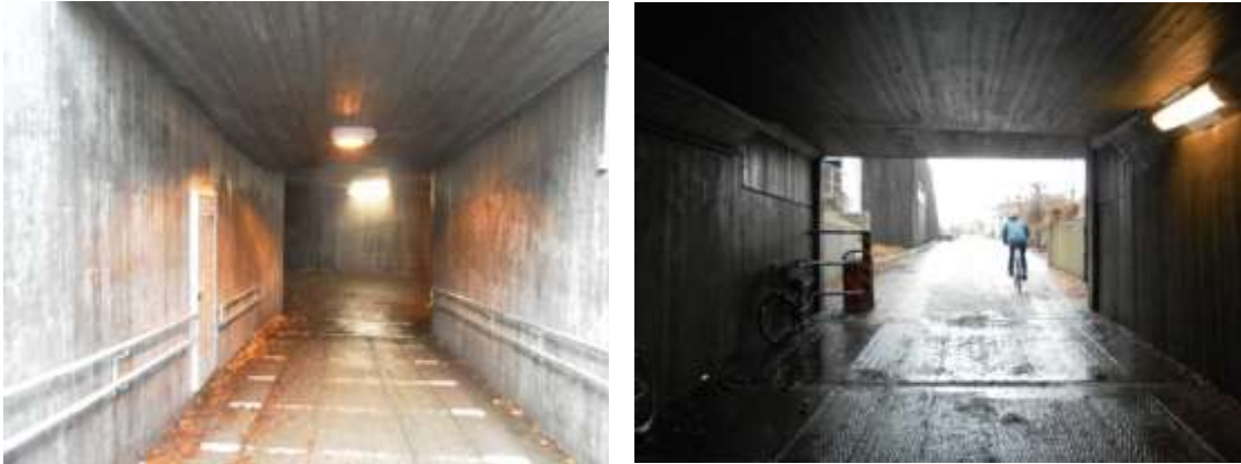
Figur 14. Nedløpet fra togperrongen i sør og undergangen med oppløp i vest.
