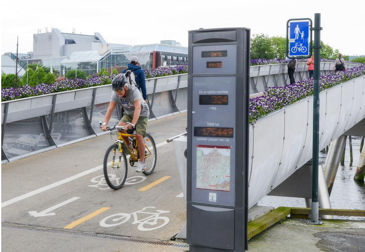
Sykkelteller ved Verftsbrua, Trondheim. Foto: Knut Opeide, Statens vegvesen
