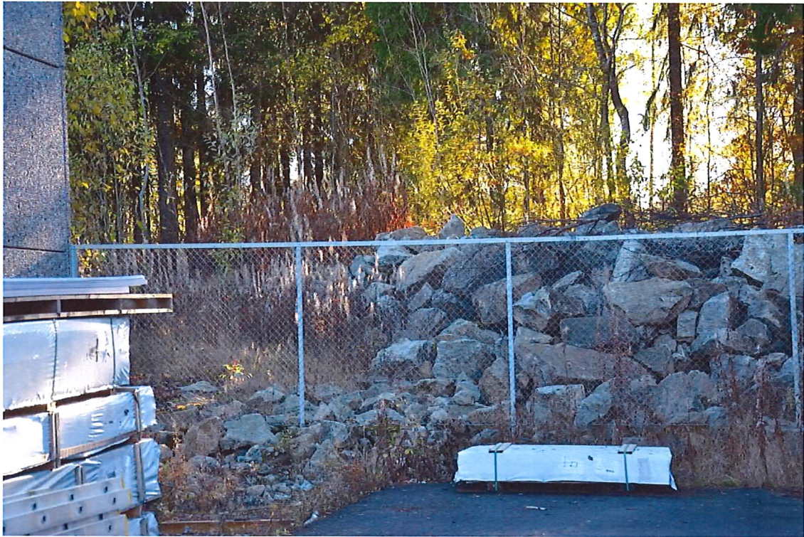
Bilde 5: Sprengstein inntil Maxbo. Bygget skal være fundamentert på berg/utsprengt berg.
