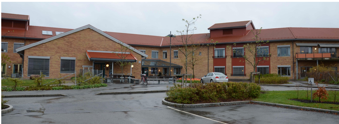
Moer Sykehjem, nærmiljø på østsiden av Brekkeveien av nyere dato.
