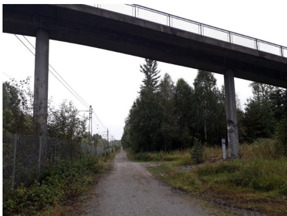
Brua ved Grønnslett.
