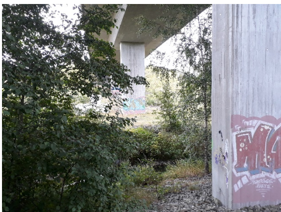
Under jernbanebrua over Bølstadbekken.
