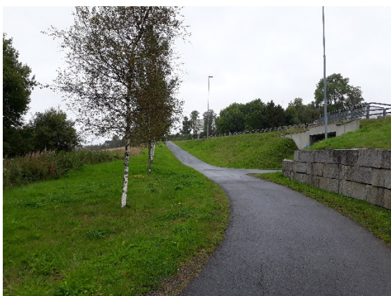
Påkoblingspunkt ved Holstad.
