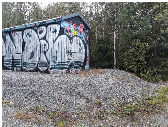
Trafobygget nord for Grønnslett.
