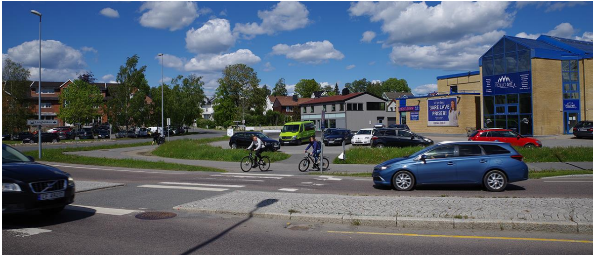
Forretningsgårder og veianlegg langs fylkesvei 152 øst i Ås sentrum
