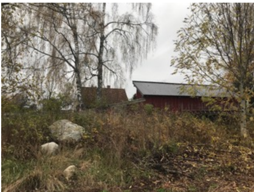
Figur 3: Uthuset til husmannsplassen Sørbråtan, sett fra sør
