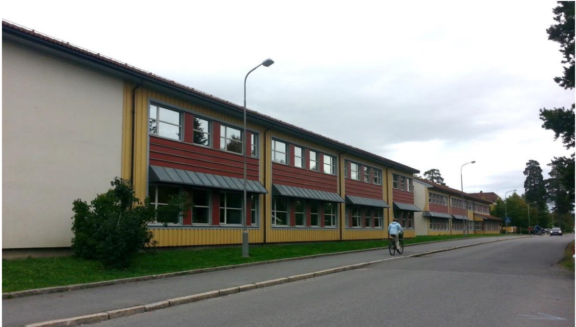
Figur 18 – Åsgård skole, Skoleveien 7. Foran på bildet sees skoleveien og fortau på nordsiden av denne. Det er relativt smalt mellom fortauet og skolebygningen, omtrent 4 m på det smaleste.
