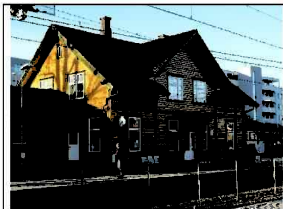
Ås stasjon oppført i 1878, etter typetegning av arkitekt Peter A. Blix for Smålensbanen som åpnet i 1879. Stasjonsbygningen er utformet i sveitserstil.
