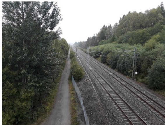
Fra brua ved Grønnslett, mot nord.
