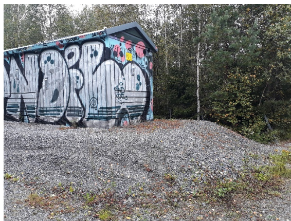
Trafobygget nord for Grønnslett.
