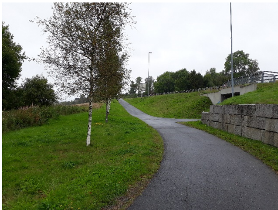
Påkoblingspunkt ved Holstad.
