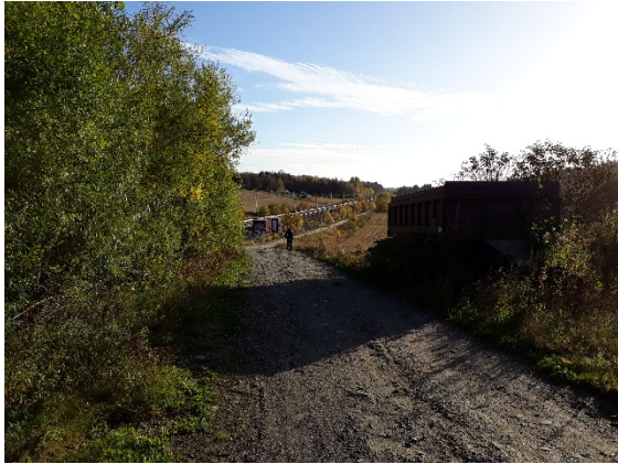
Ved brua ved Haugerud, mot sør.
