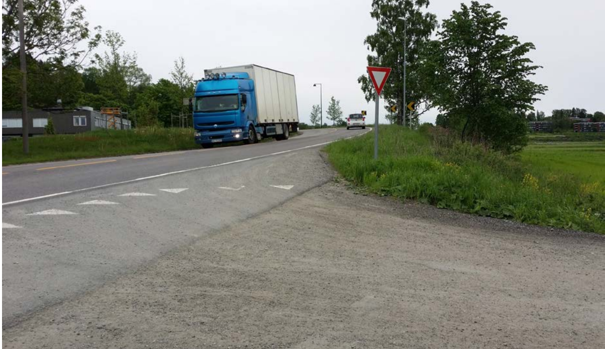
Figur 10 Veien over Kjerringjordet får dårlig sikt østover.
