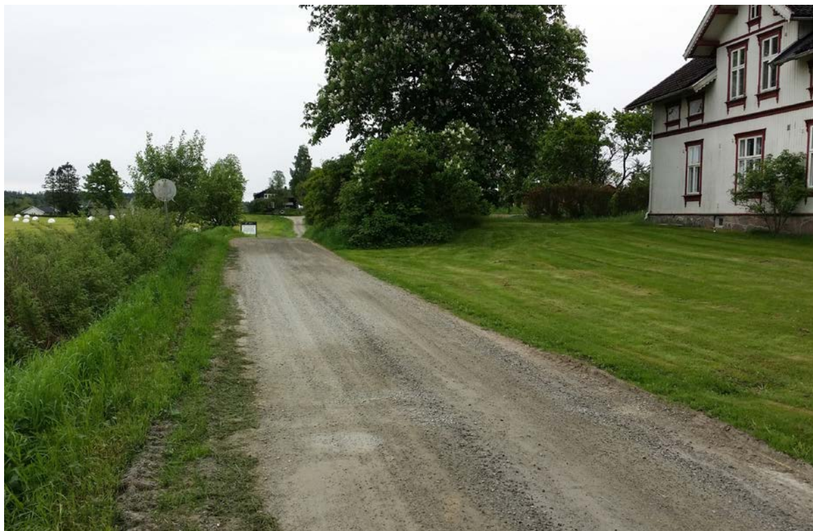
Figur 3 Vollveien er en typisk gårdsvei som krever utbedring og breddeutvidelse for å kunne bli atkomstvei til Vollskogen.
