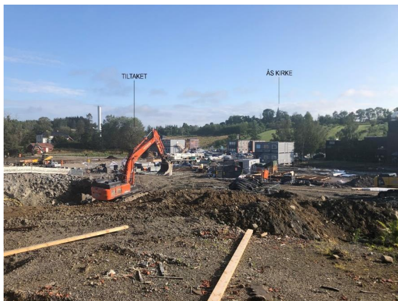
5-1 Planområdet sett fra Fougnerhaugen
