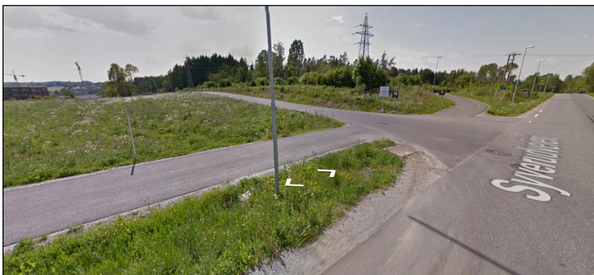
Figur 6 T-krysset Arboretveien X Syverudveien (kilde: google streetview fra juni 2016).
