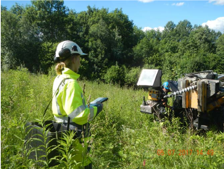
Figur 4: Bildet viser vegetasjon for deponiområde ved Askehaug gård, samt borerigg.
