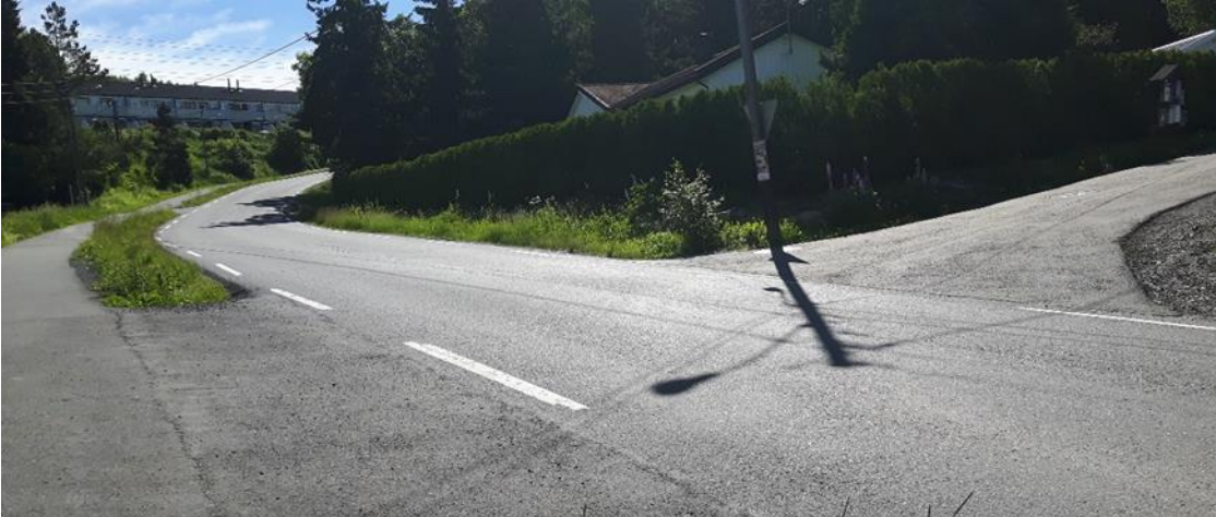
Bilde 8: Adkomsten til Askehaugåsen fra Askehaugveien sett mot øst.
