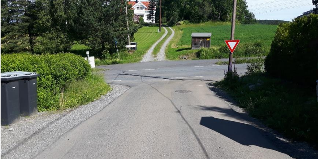
Bilde 3: Askehaugåsen sett mot Askehaugveien i nord.
