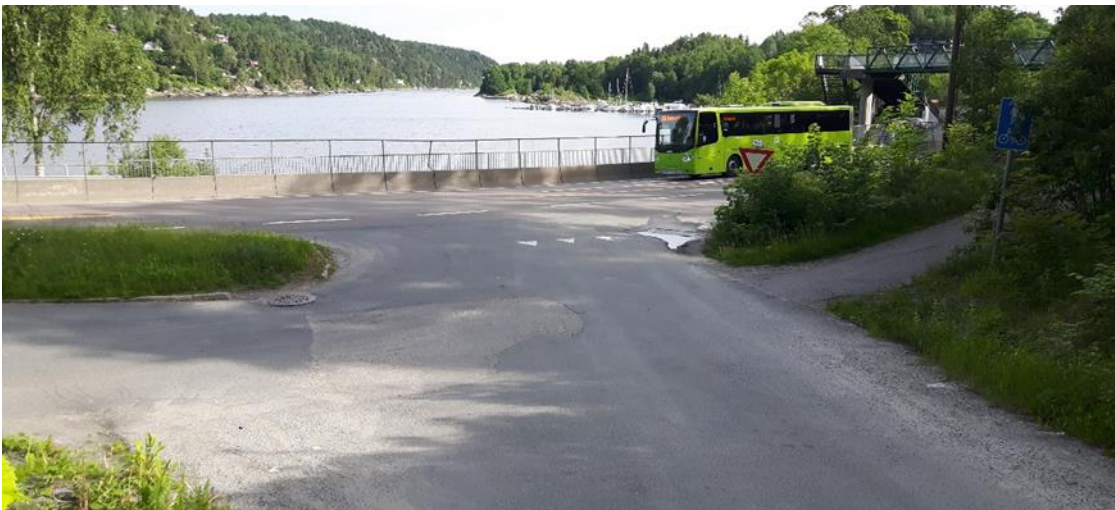
Bilde 2: Krysset Bekkveien/Nedre Bekk vei x Nessetveien sett mot vest.
