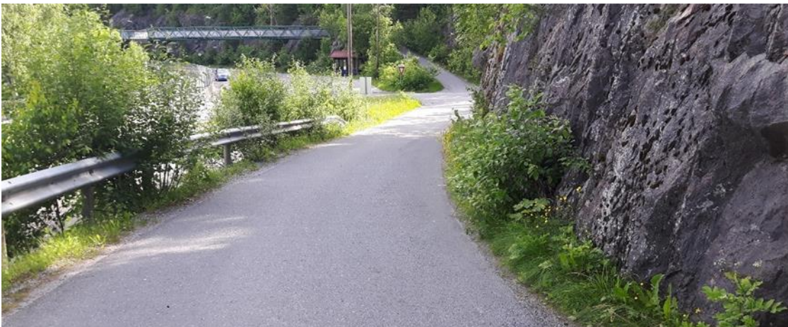
Bilde 7: Nedre Bekk vei mot krysset ved Bekkveien/Nettetveien sett mot nord.
