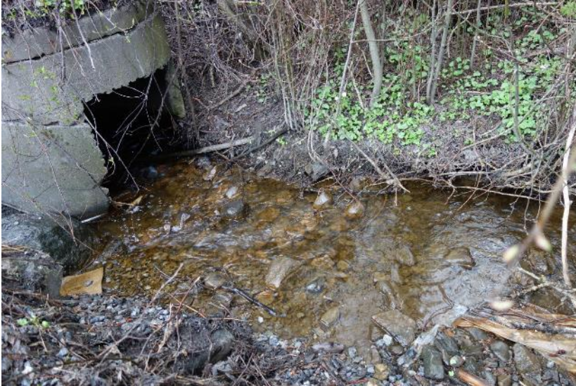
Figur 17: Prøvestasjon 2 lå tett på en kum, hvor bekken forsvant under Nessetveien.
