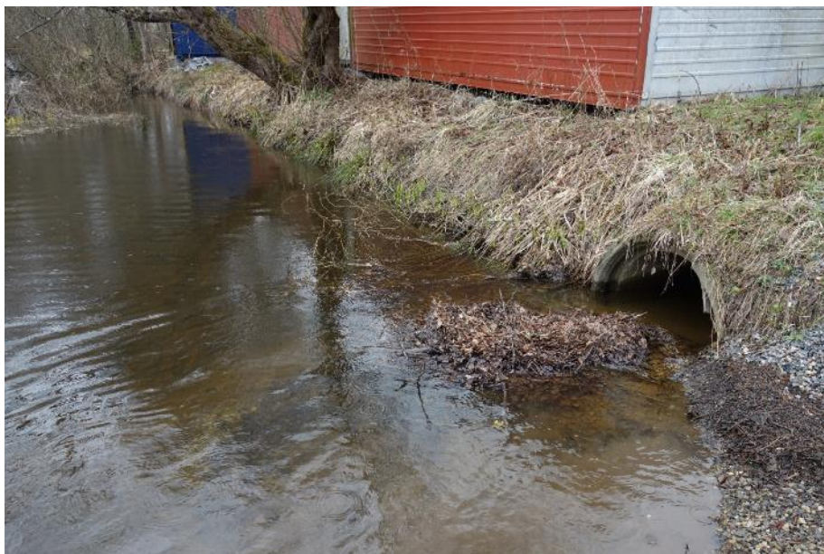
Figur 20: Utløpet fra en større kulvert til Flåbekken. Etter at det ikke ble funnet flere utløpskulverter langs Flåbekken, antas det at dette er bekken fra Prøvestasjon 2 som renner ut i Flåbekken.
