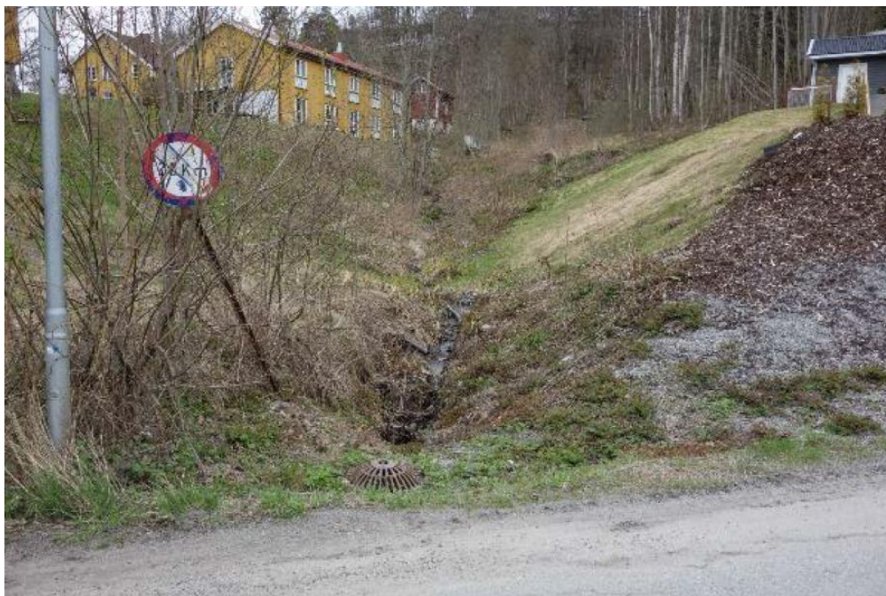
Figur 10. Innløpet til stikkrenne nr. 7 under Nedre Bekk vei, med utløp til Bekkelva. Gjengitt fra rapporten Naturmiljøvurderinger (Multiconsult, 2018b).
