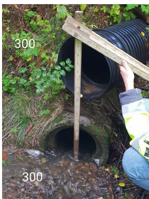
Figur 7. Innløp stikkrenne nr. 1. Bilde fra befaring i september 2018.
