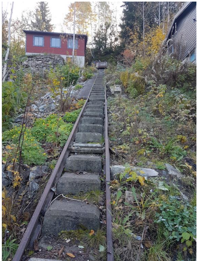
Trapp med skinner for fraketralle i Markusløkka 6 (reg.nr.294)
