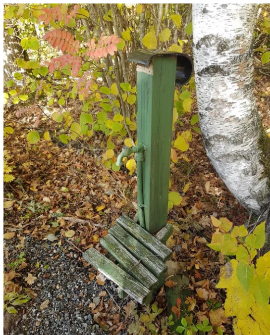
Øverst i Bekkveien finner vi denne vannposten.
