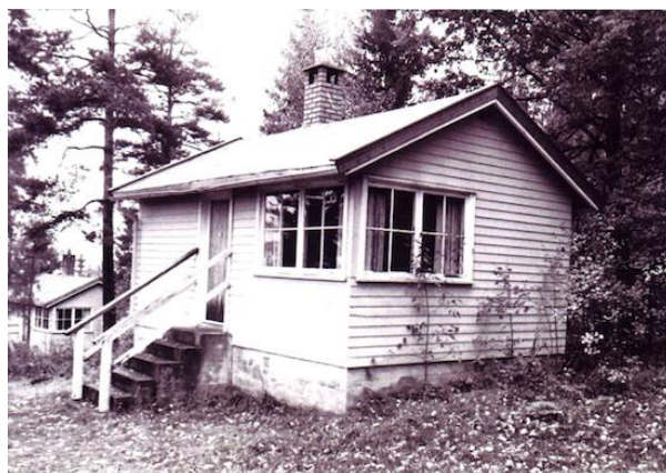
Hytte nr. 5 og 6 i opprinnelig utførelse
