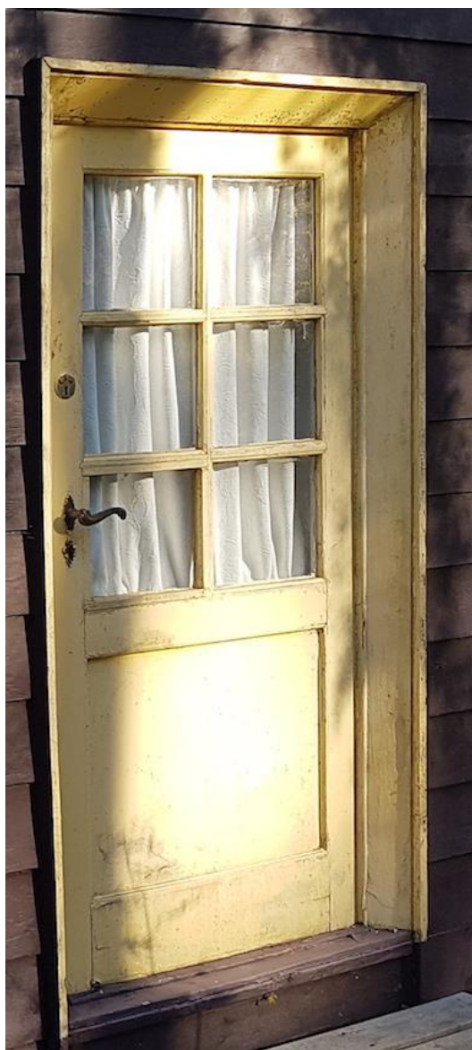
Særpreget belistning rundt dør og vinduer. Ringveien 7 (reg.nr 262)
