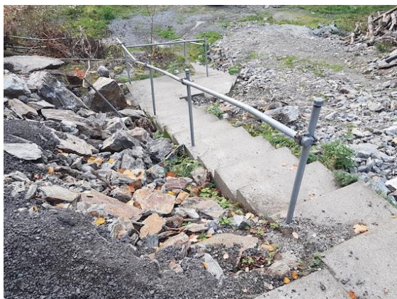
Ny trapp ned til Nesset etter gravearbeider.
