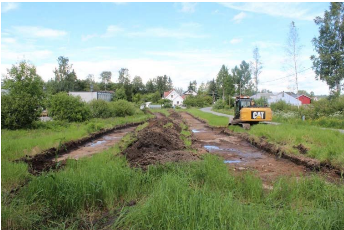
Fig.6 Oversikt over den undersøkte delen av planområdet på gbnr. 52/1. Sett mot nord.
