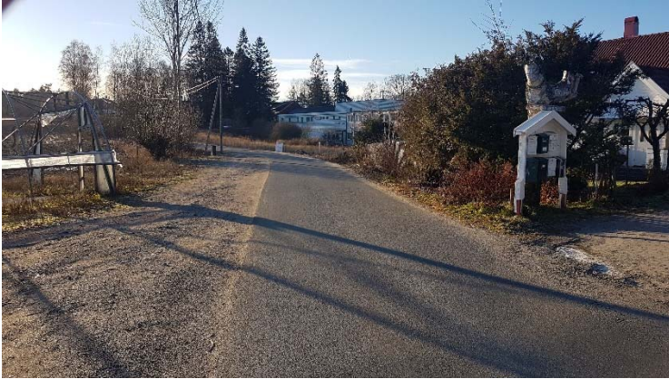
Planområdet sett fra Brekkeveien mot sør.
