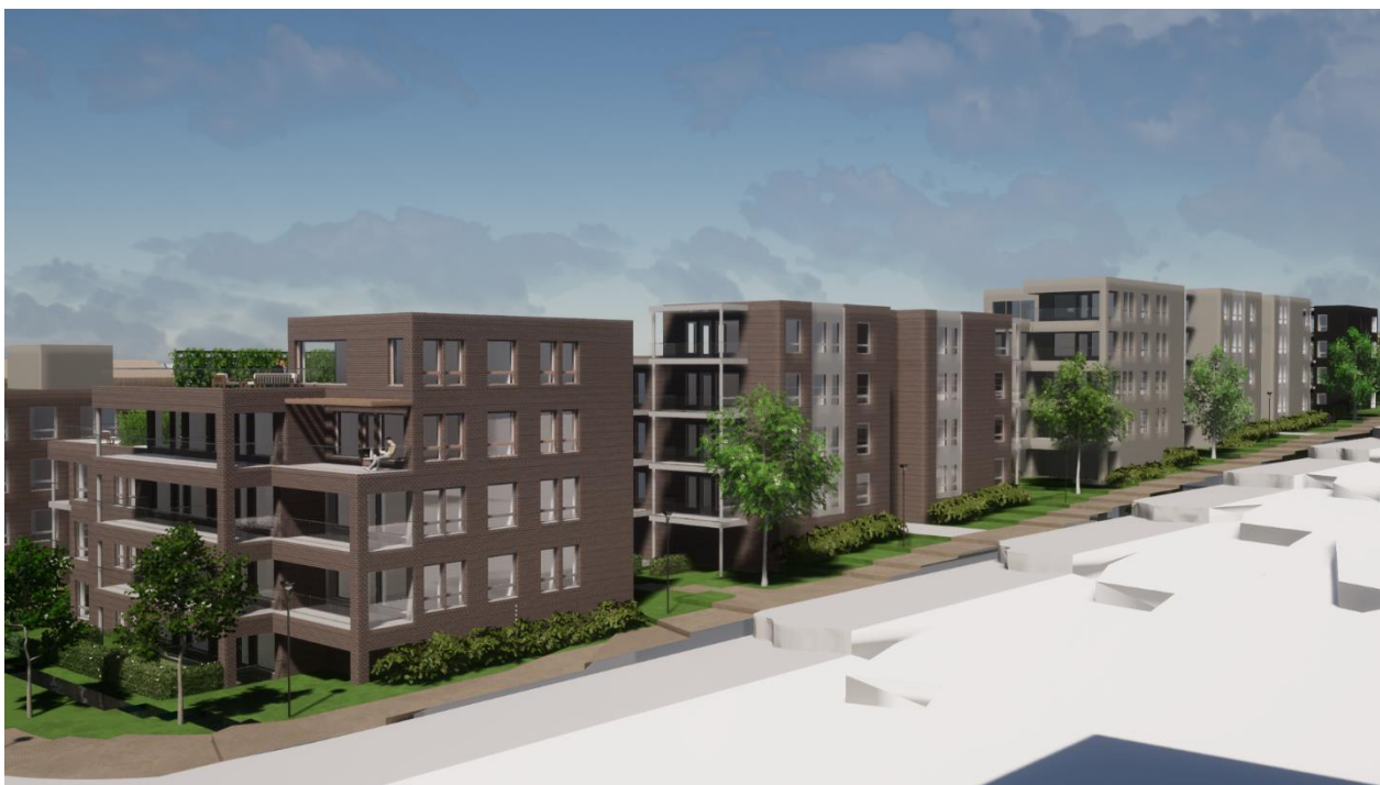
Ill. 19 Felt B3 – Her er fire bygg som ligger langs Langbakken, med innganger fra veien. Byggene ligger i jevnt fall, i en kjede langs veien. Annenhvert bygg er lagt på langs og på tvers av veiens retning, og dette gir opptakt til tunformer vest for byggene. Byggene er tilpasset terrenget, i fallet mellom veien og tunene
