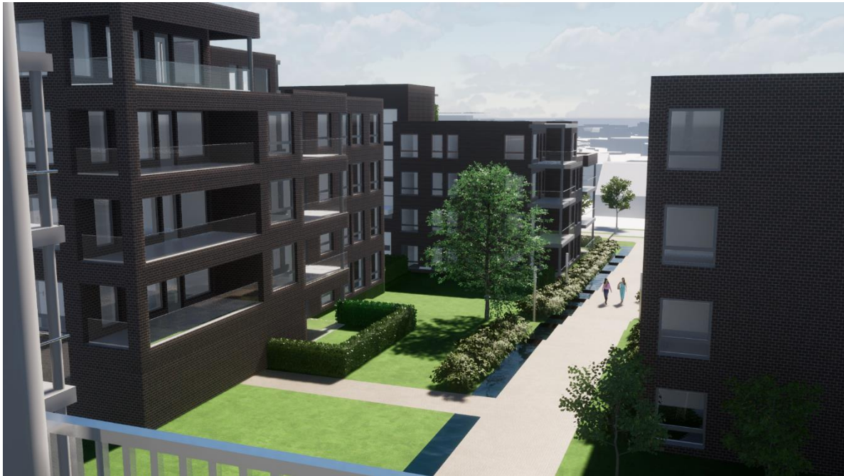
III.39 Romlige forhold – samme motiv som nederst på forrige side, sett fra balkong
