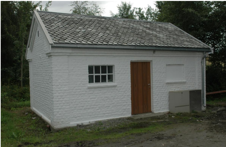
Figur 8. Nordby kabelhus fra 1924-25.
