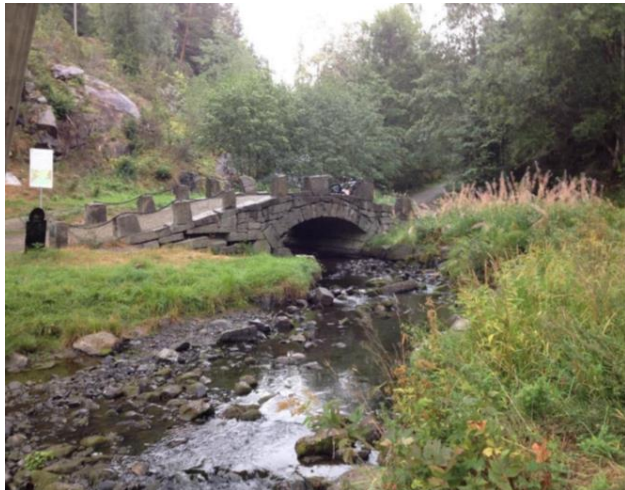
Steinhvelvsbroa over Dalsbekken. Foto: Ås kommune
