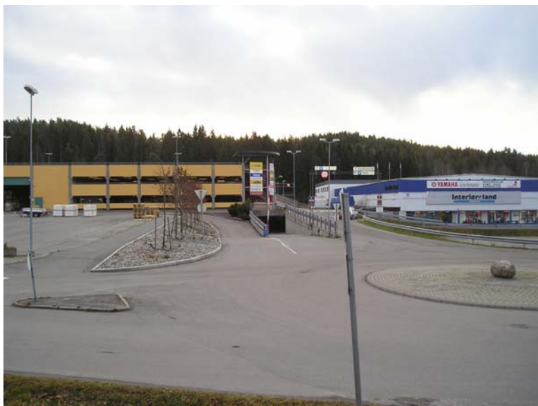
Atkomst til/fra p-hus skjer rett fra rundkjøring. Her er det innkjøring til p-hus, og til markparkering i vest til høyre, utkjøring fra p-hus i midten og utkjøring fra markparkering til venstre. Dette punktet er uoversiktlig, og de ulike funksjonene bør separeres i større grad. Foto: Magne Fjeld
